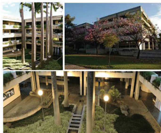
Figura 1 – Perspectivas fotográficas do prédio da ECI.
